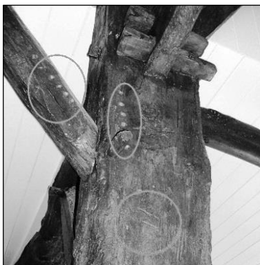
verschillende soorten telmerken die verraden dat het gebinte is hergebruikt, en dus eerst ergens anders heeft dienst gedaan
