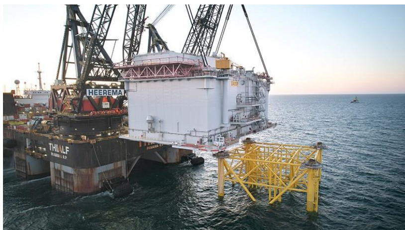
De installatie van een 'stekkerdoos' (gewicht 10.000 ton!) in windmolenpark op de Noordzee (april 2023)
