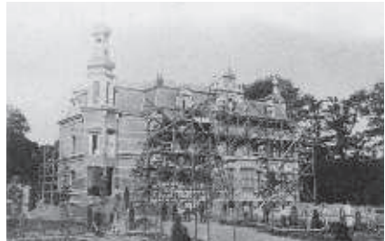
Het nieuwe huis in aanbouw. Links nog een gedeelte van het oude huis.
